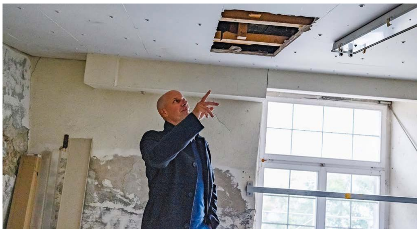
Christian Werner, Leiter des Hochbauamts, zeigt eine der «Sondagen». Mithilfe dieser soll der Zustand des alten Gebäudes untersucht werden.
