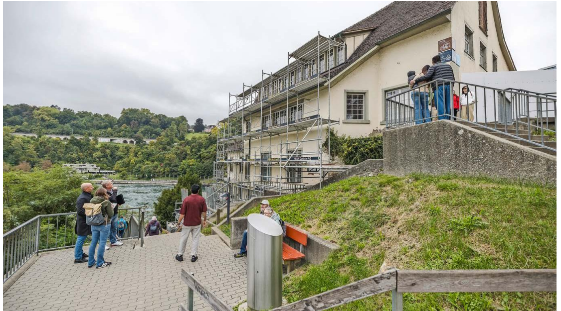
Das Mühleradhaus ist fast komplett eingerüstet. Hierfür war die Hilfe von Industriekletterern nötig.
