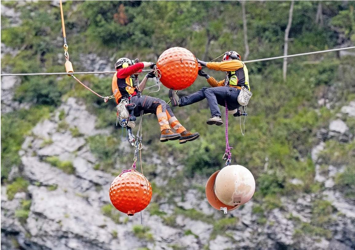
**Spezialisten wechselten** am Montag mithilfe eines Helikopters die Warnleuchtkugeln für die Starkstromleitung der Linie Airolo-Mettlen in Erstfeld. Die nationale Netzgesellschaft Swissgrid orientiert an einem Medienanlass über die Neuverlegung der Hochspannungsleitungen, welche neu durch den Gotthardtunnel statt über den Gotthardpass führen sollen.
